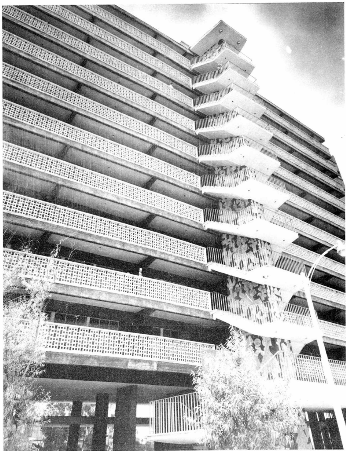
Figura 5. Multifamiliar Presidente Juárez, arquitectos Mario Pani y Salvador Ortega, 1952. Edificio de diez pisos con la escalera decorada con relieves en concreto policromado al frente. Estos edificios, cinco en total, fueron demolidos a consecuencia del sismo de 1985 (foto Zamora).
