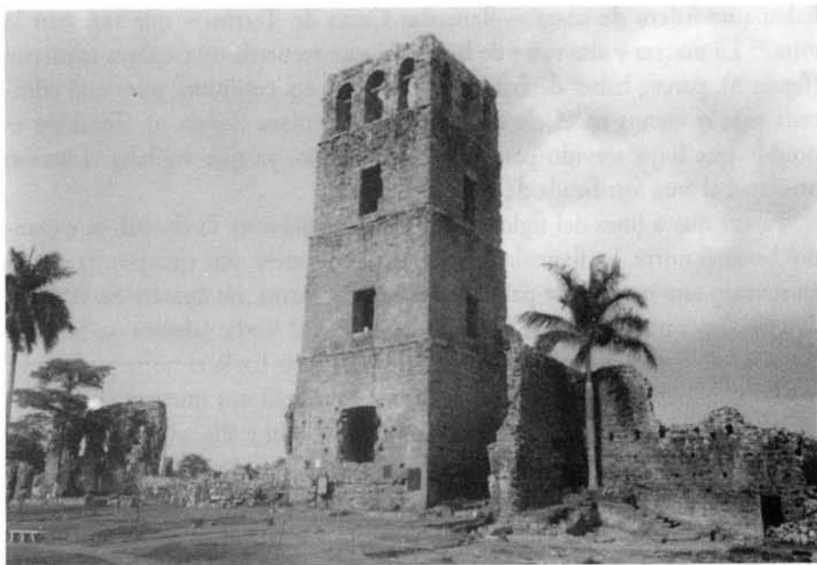
Figura 8. La torre de la catedral de Panamá la Vieja, con la Plaza Mayor a su frente. A la derecha se ven las ruinas del cabildo, donde se estaba llevando a cabo una prospección arqueológica cuando se tomó esta foto en marzo de 1996. Foto: E.T.D.
