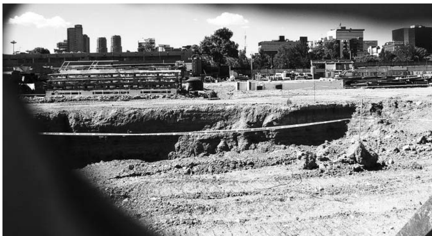
3. La acelerada destrucción de la fábrica de automóviles Chrysler, ubicada en la colonia Anáhuac, en donde los programas recientes de desarrollo urbano permiten una densidad de construcción de 19 a 30 niveles, lo cual propicia la demolición total de extensas áreas industriales. Foto: María Bustamante Harfush, abril de 2004.
