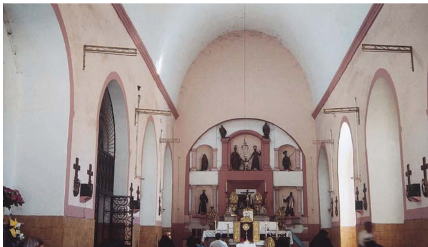
7. Nave con bóveda de cañón corrido, iglesia de Jesús, María y José. Foto: CGA, 2004.
