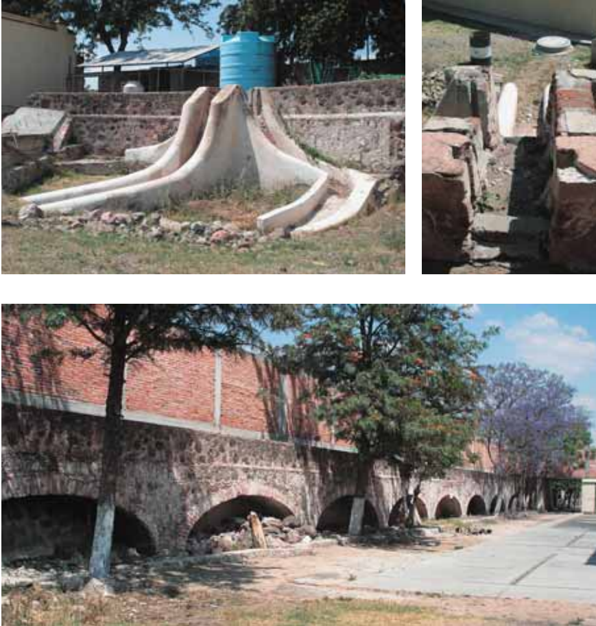
11. Acueducto. Fotos: Andrés Torres Acosta, febrero de 2007.
