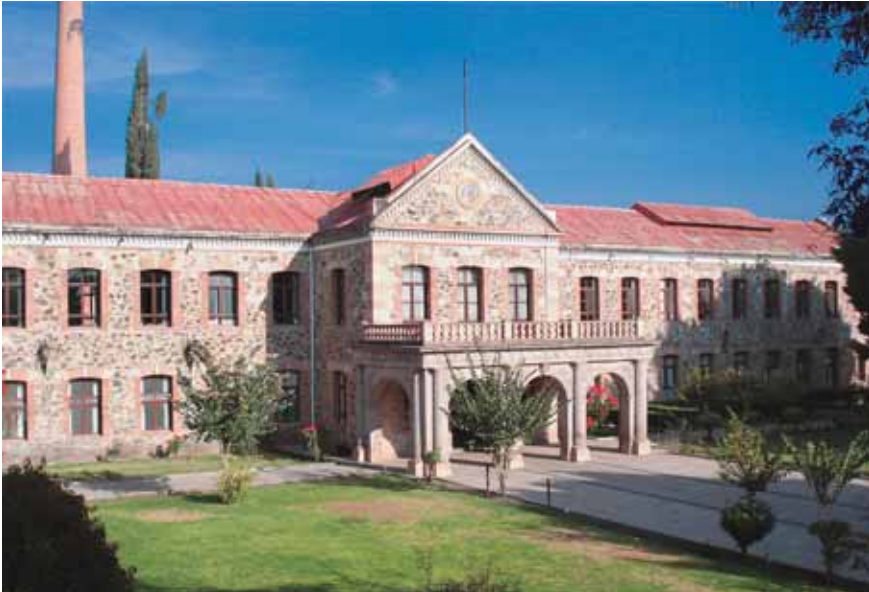
6. Fachada del antiguo molino de San Antonio mostrando el acabado actual. Foto: Andrés Torres Acosta, febrero de 2007.
