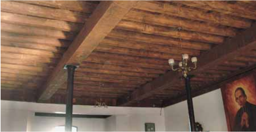
8. Interior del edificio principal. Fotos: Andrés Torres Acosta, diciembre de 2008.
