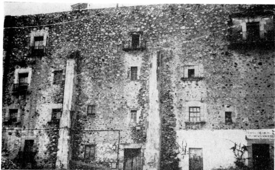
Figura 4. Fachada posterior de la "Casa Borda" de Taxco.
