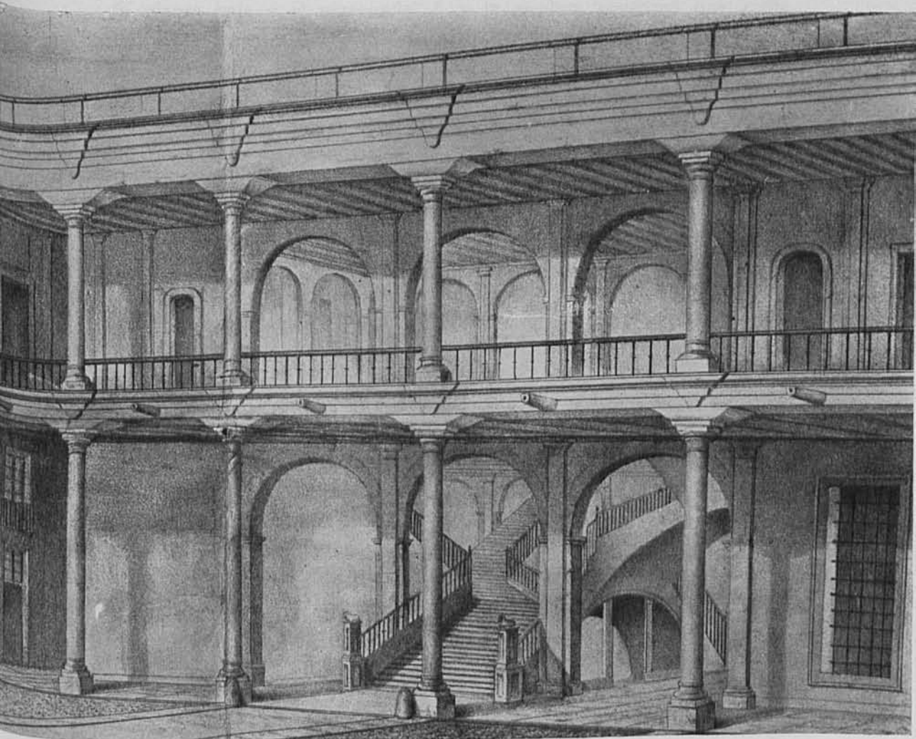
5. México, D. F. Ex aduana de Santo Domingo. Patio principal. Litografía siglo XIX. Foto Archivo del I. N. A. H.
