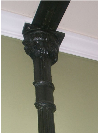
6. Columna de fundición en el interior de la vivienda. Foto del autor.
