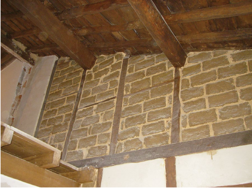
8. Tabiques interiores con entramado de madera y adobe en el edificio auxiliar. Foto del autor.
