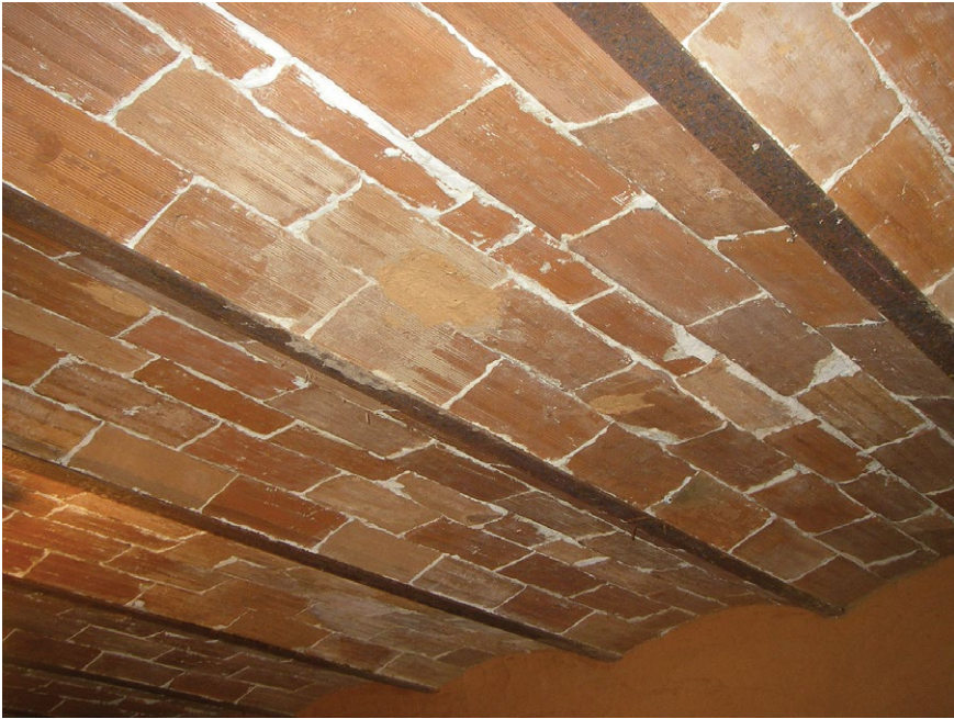
7. Viguería con perfil de doble T que sustenta las bovedillas de rasilla. Foto del autor.
